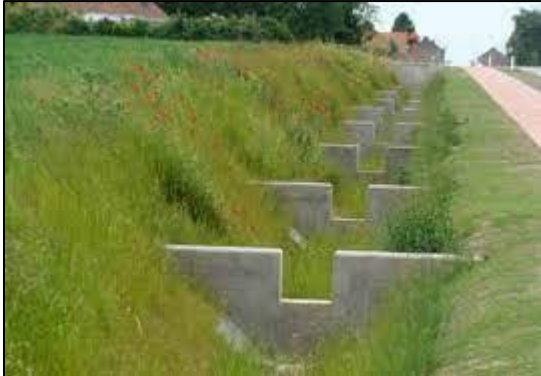
Figuur 91: Gracht met stuwconstructies (Milieuinfo, 2021)
