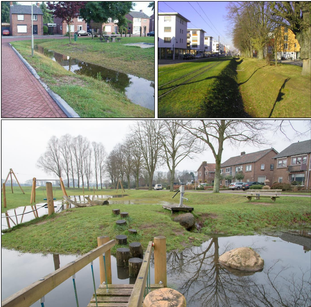
Figuur 89: linksboven: straat watert af naar wadi (Devee, 2021), rechtsboven: infiltratiegracht (Gemeente voor de toekomst, 2021), onder: multifunctionele inrichting met wadi en speelzone (ClimateScan, 2017)
