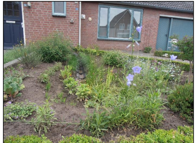
Figuur 87: Regenwater naar wadi in voortuin (links: aanleg wadi, rechts: aanplant wadi) (van Eck, 2016)
